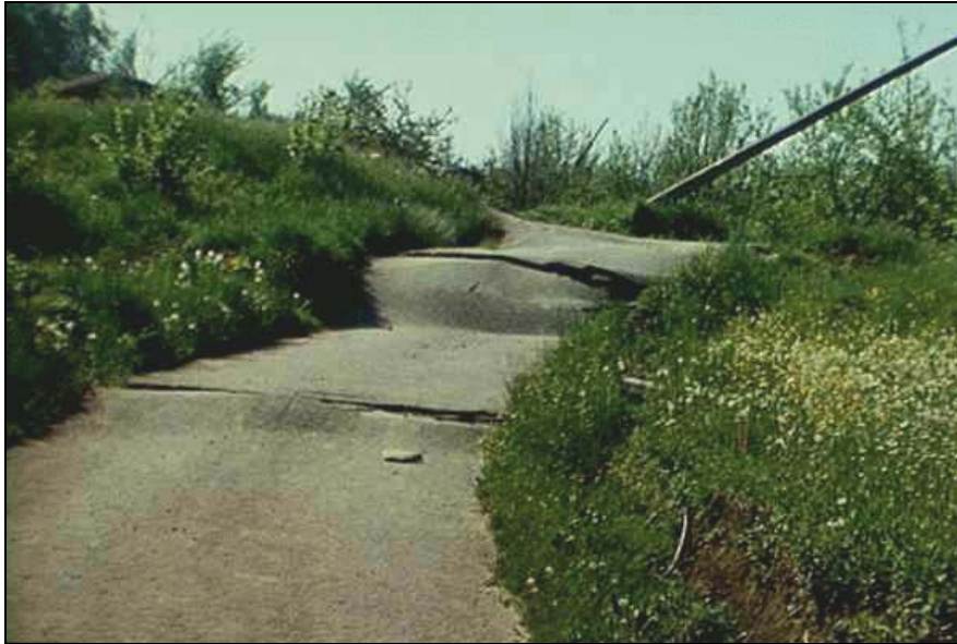
Deformazione del solido stradale
