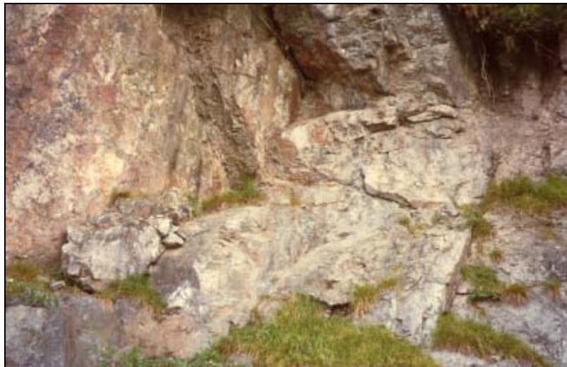
La roccia presenta una colorazione rossastra ad indicare l'elevato stato di alterazione
