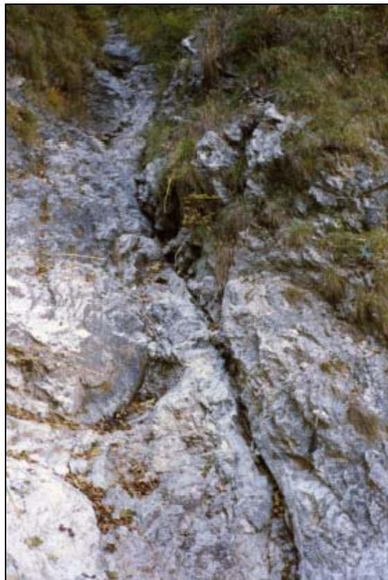
Frattura con apertura ridotta che non causa grossi problemi di instabilità
