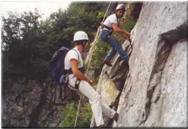
Figura 2.3: Disgaggio effettuato da guide alpine (a sinistra) e da una macchina autoelevatrice (a destra)
