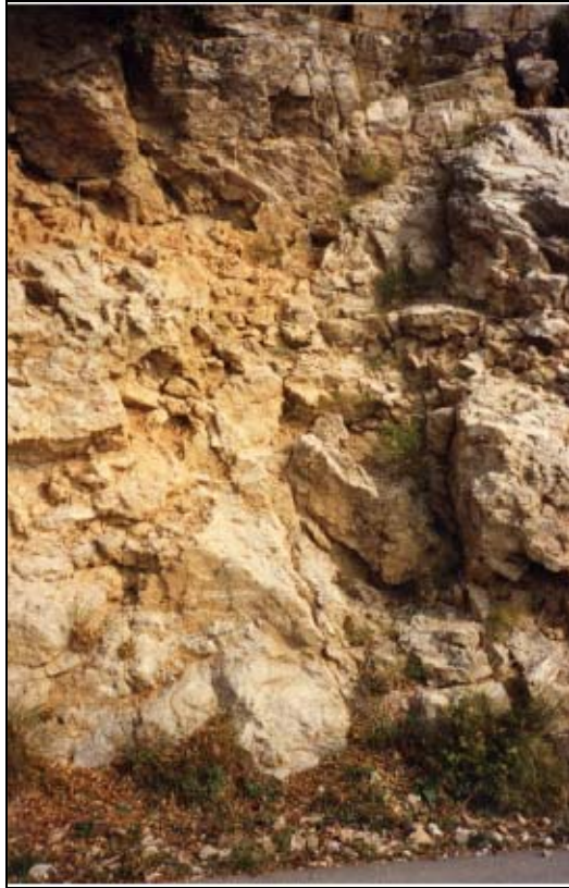
La roccia presenta una tipica colorazione giallo-ocra ad indicare l'elevato stato di alterazione
