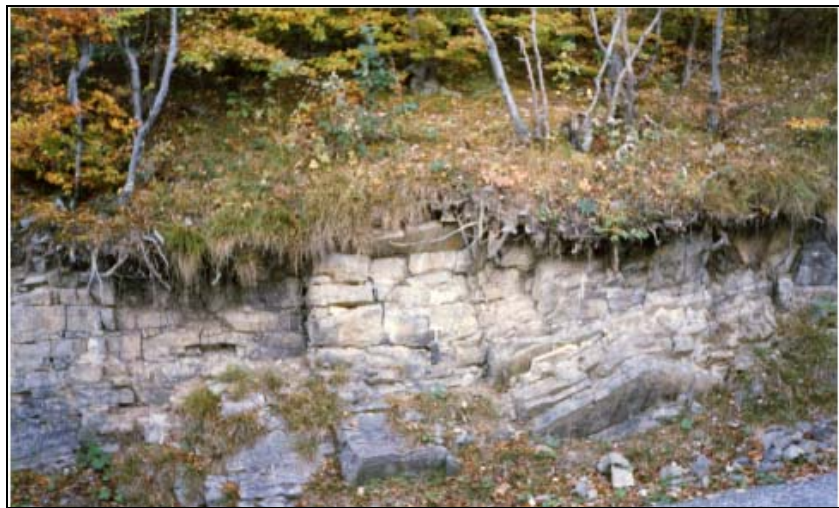
Versante caratterizzato da altezza ridotta: situazione non pericolosa
