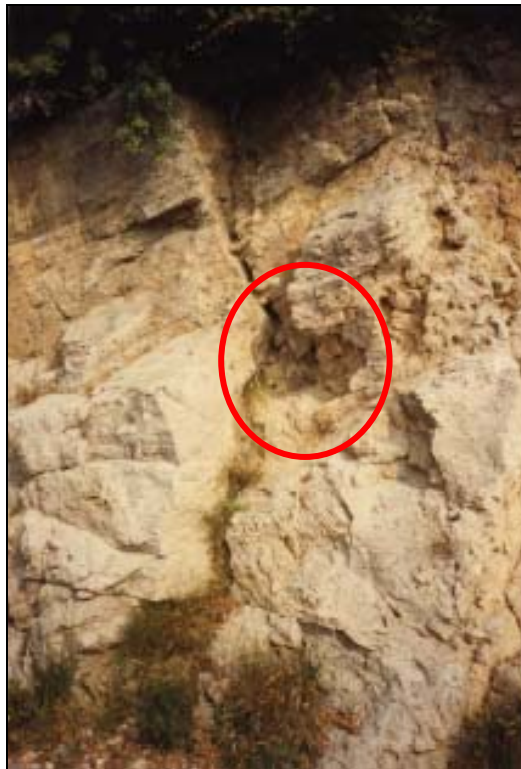
Ammasso roccioso con blocchi privi di un sostegno alla base (in rosso)
