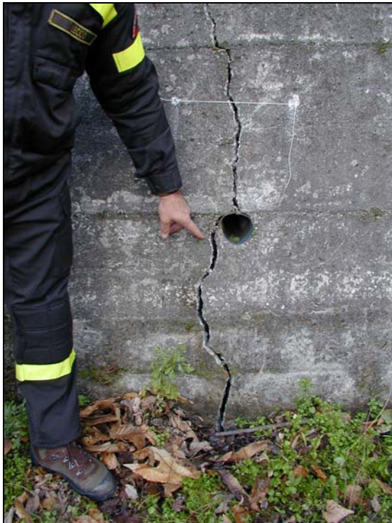
Lesione su un muro causato da movimenti del terreno
