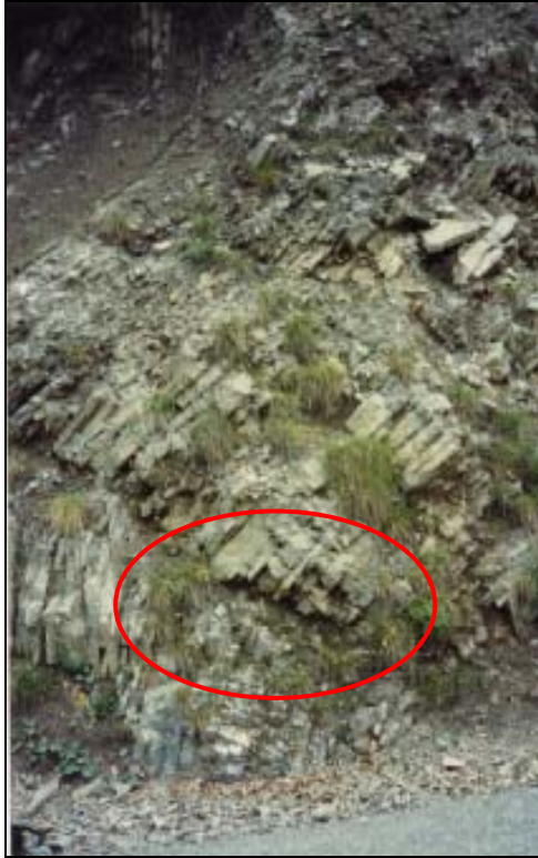
Ammasso roccioso fittamente stratificato con frattura che aggrava l'instabilità del versante
