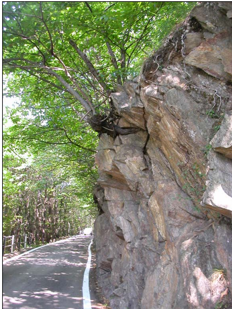
Le radici delle piante si insinuano nelle fenditure della roccia allargandole sensibilmente
