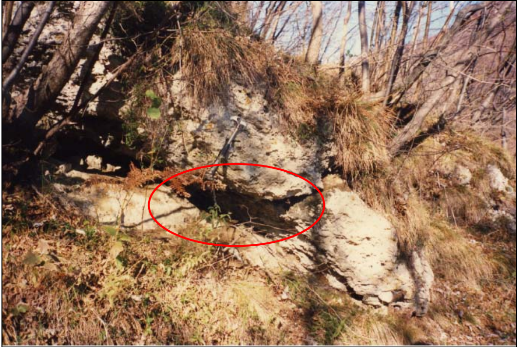
Ammasso roccioso caratterizzato da una frattura aperta e priva di riempimento che isola un blocco di roccia fortemente instabile
