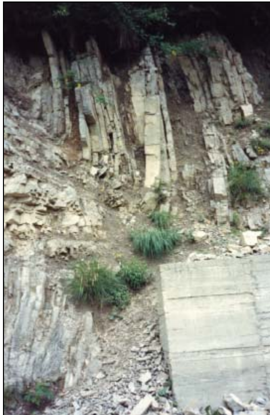
Accumulo di materiale alla base di un versante soggetto a frane di crollo
