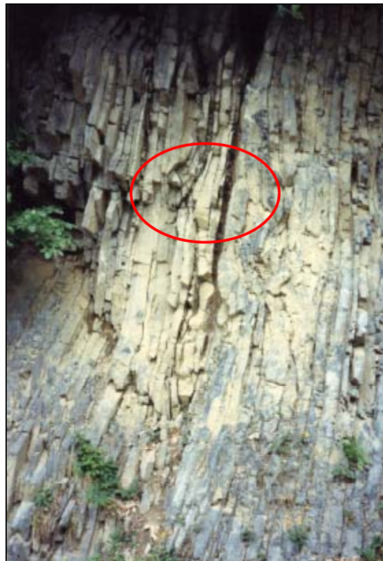
Ammasso roccioso interessato da discontinuità verticali che isolano, unitamente a fratture perpendicolari, blocchi instabili.
