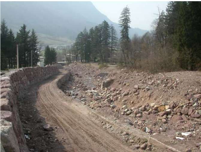
Figura 2.34: Parte laterale di un cuneo deviatore
