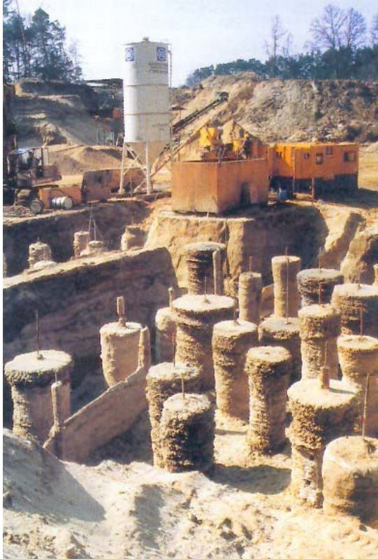
Figura 2.24: Pali in terra
